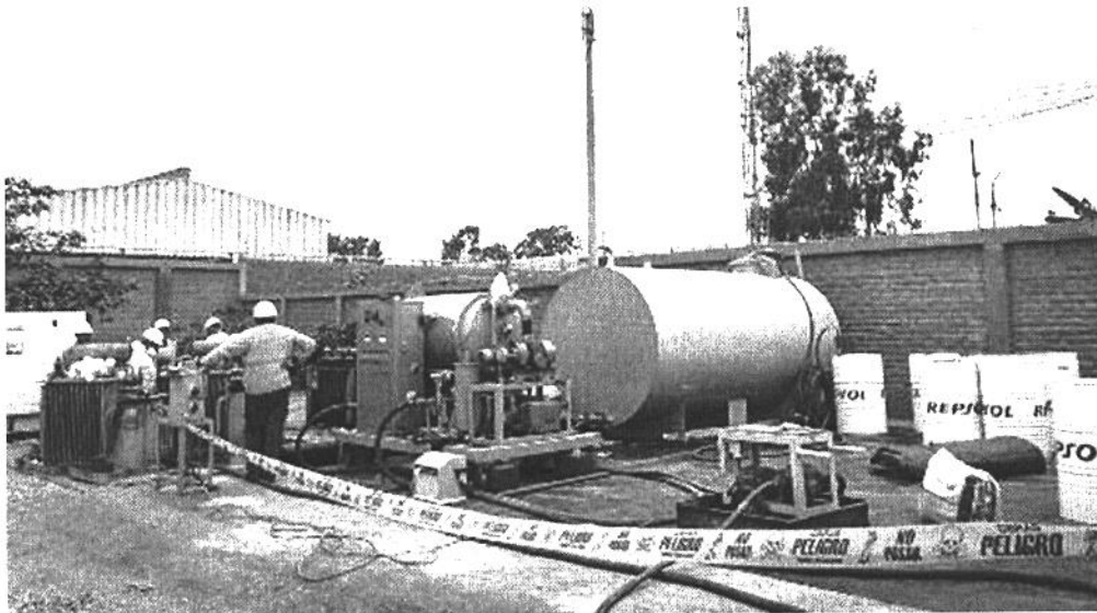
Figura N° 29: Equipo utilizado para el proceso de retrolleado
