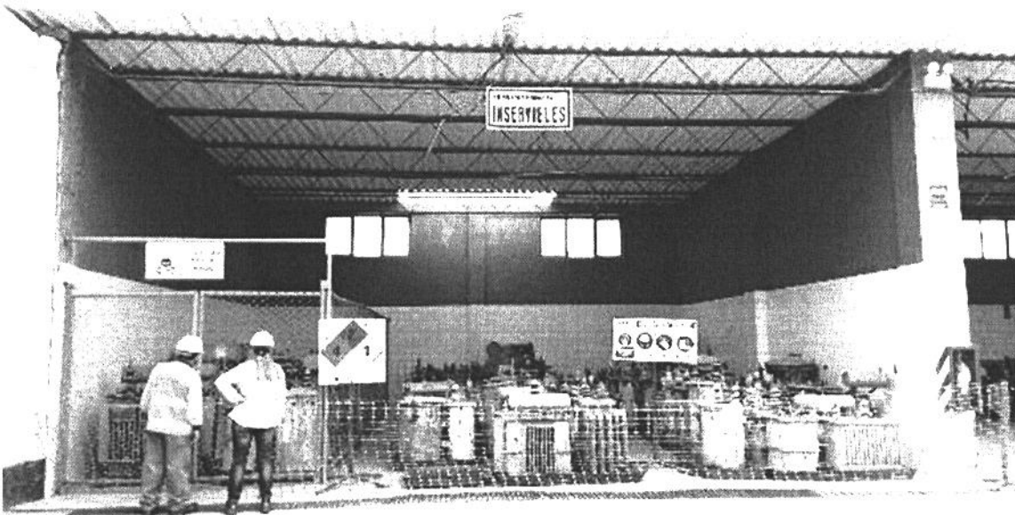
Figura N° 23: Área de almacenamiento de PCB dentro del almacén de residuos peligrosos
