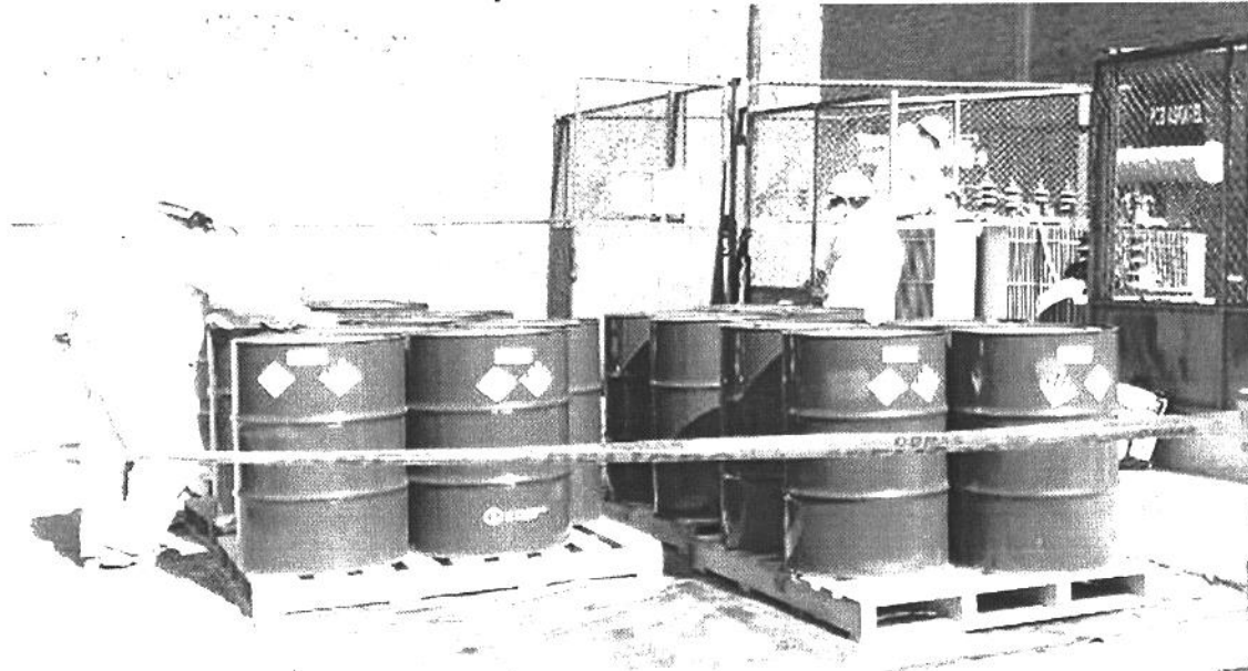
Figura N° 19: Cilindros NNUU conteniendo aceite con PCB listo para ser transportado hacia el Puerto
