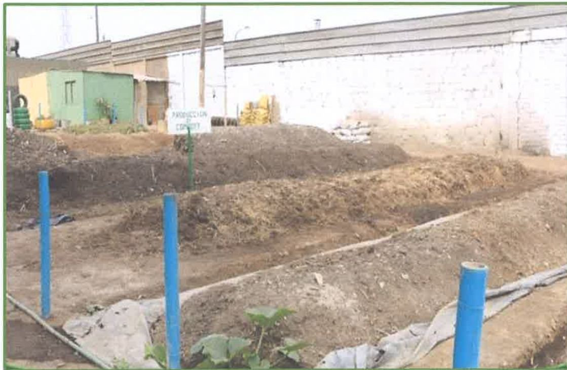
Imagen N° 1 Planta piloto de Valorización de Residuos Sólidos Orgánicos Municipales
