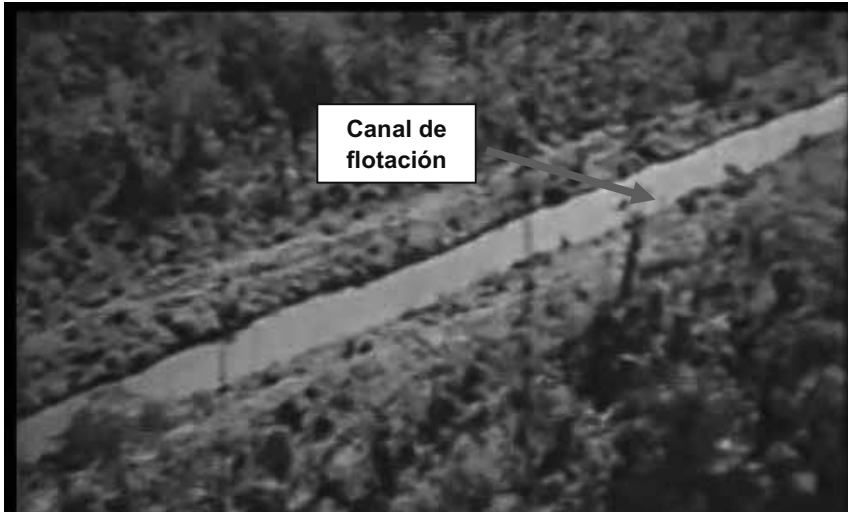
Foto N° 5. Vista panorámica del canal de flotación, del video “Conoce cómo se construyeron el Oleoducto Norperuano y los canales de flotación”
