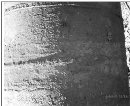
Fotografía N° 3 del 23 de julio del 2014 consignada en el Informe N° 0379-2014-OEFA/DS-HID elaborado por la Dirección de Supervisión el 26 de setiembre de 2014. Se describe la severa corrosión externa en la unión soldada (cordón de soldadura), expuesta es decir sin pintura y/o algún tipo de recubrimiento, que evite el deterioro del ducto por un proceso corrosivo externo. Tramo comprendido entre el Kilómetro 40 y 42 del ONP.
