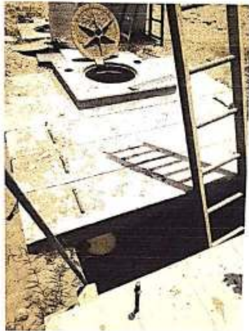
Foto 3: Vista de la construcción del tratamiento secundario de aguas residuales domesticas con floculantes y coagulantes.
