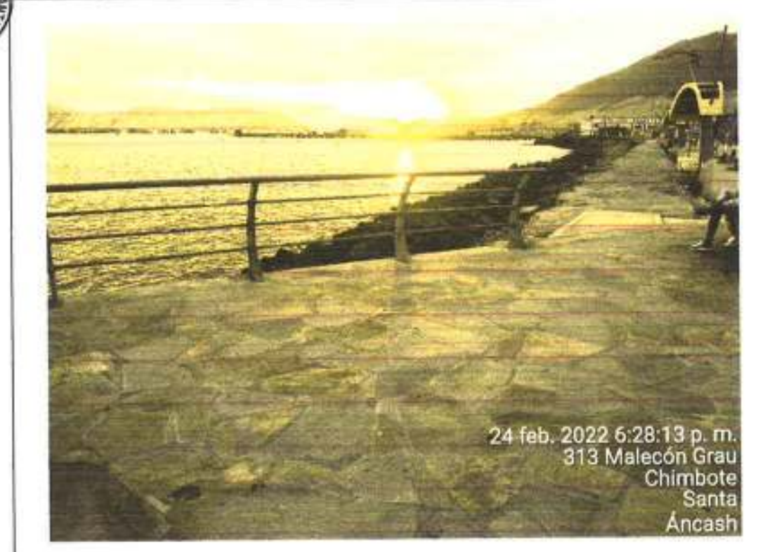
Registro fotográfico 02. Chimbote 24/02/2022 – Vista de la zona superior del enrocado del malecón Grau sin presencia de bolsas negras conteniendo cajas de pop corn.
