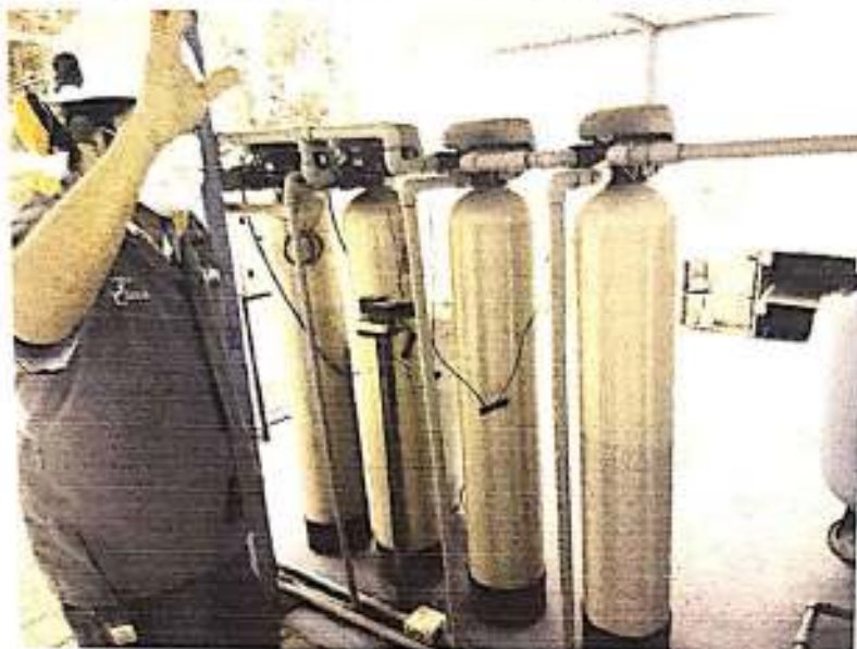
Foto 1: Sistema de tratamiento de agua para ablandamiento del agua de proceso en la elaboración de envases de hojalata.
