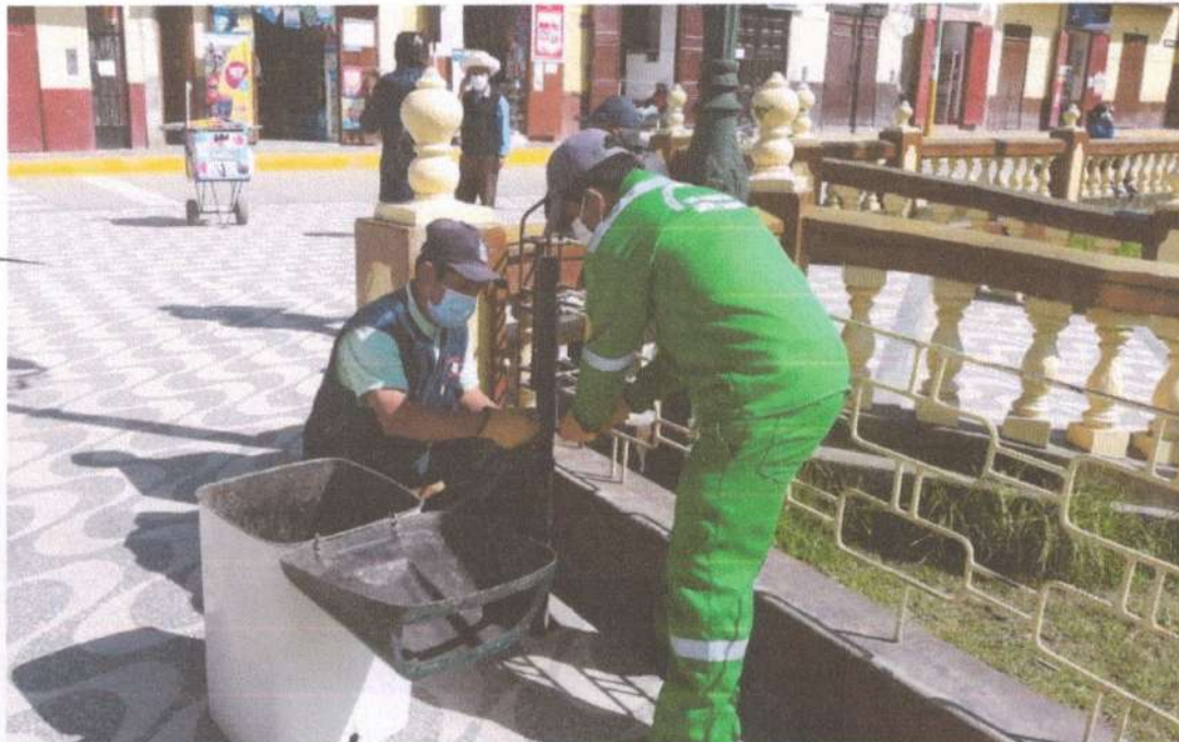
Figura 09: Instalación de dispositivo de almacenamiento
