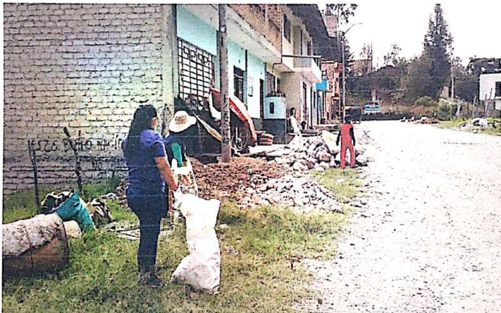
Limpeza para la intalación de jardines ecológicos en el Jr. Tacabamba
