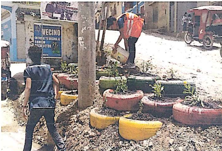
Instalación del jardín ecológico en el Jr. Tacabamba
