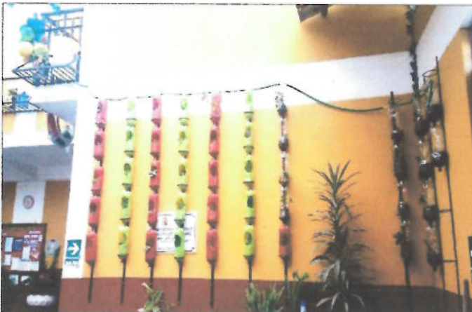
Agricultura urbana: instalación de jardín vertical en la Institución Educativa N° 82011 los Rosales
