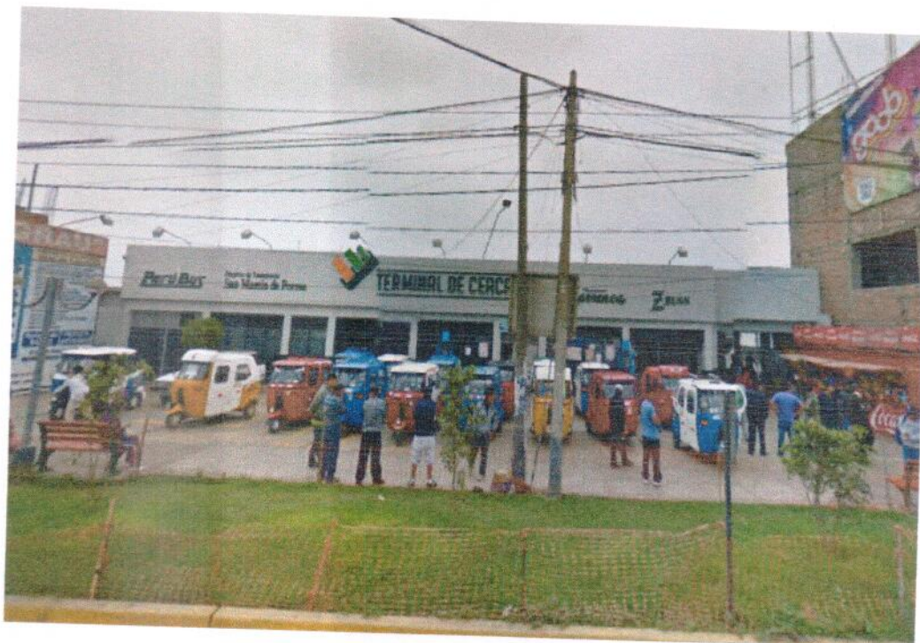
Terminal Terrestre de Huacho
