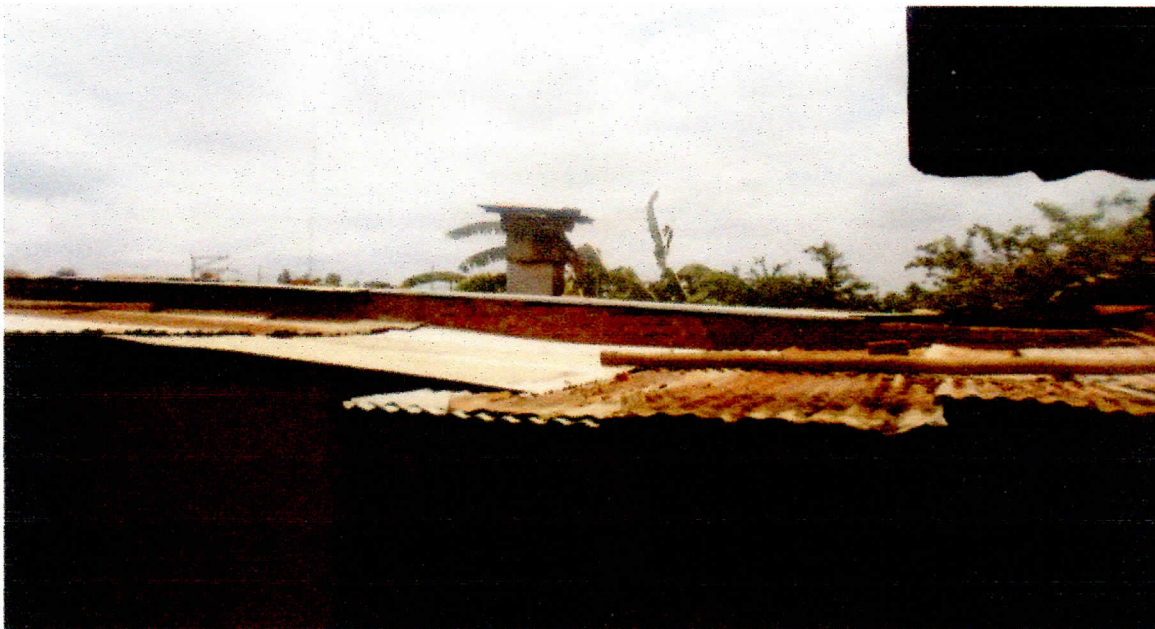
SE OBSERVA EL CUELLO DE LA CHIMENEA A PROLONGAR
