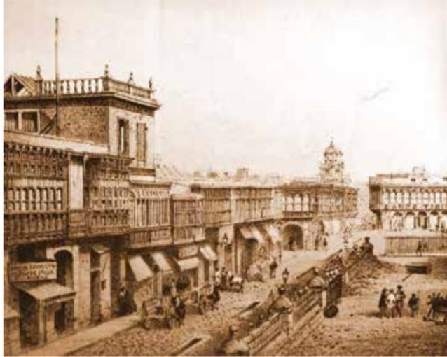
Obras de alcantarillado, empedrado y alumbrado a gas (1867)
