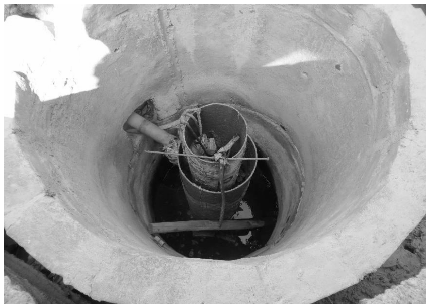
Imagen 3. Pozo mixto, antepozo de concreto y tubería de acero
