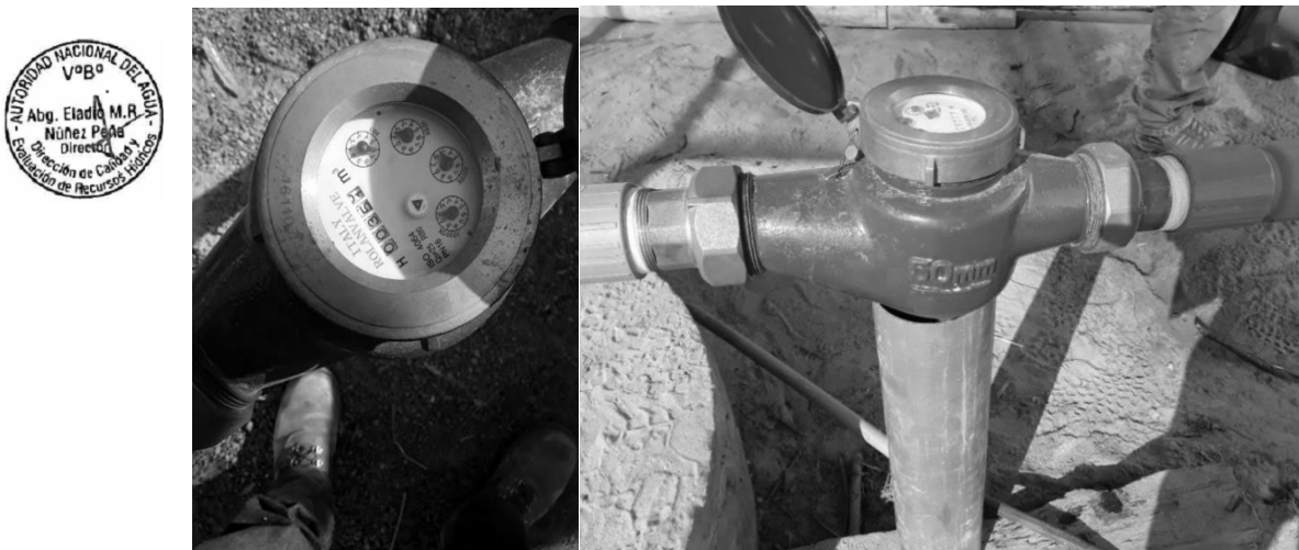
Imagen N° 1 Medidor tipo chorro
