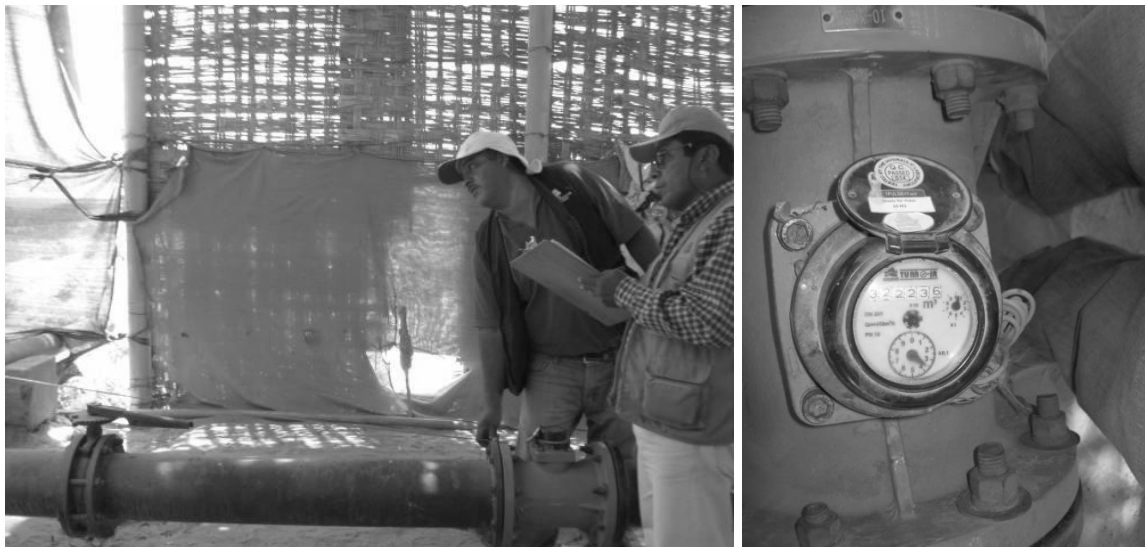
Imagen N° 3 Medidor tipo Tangencial
