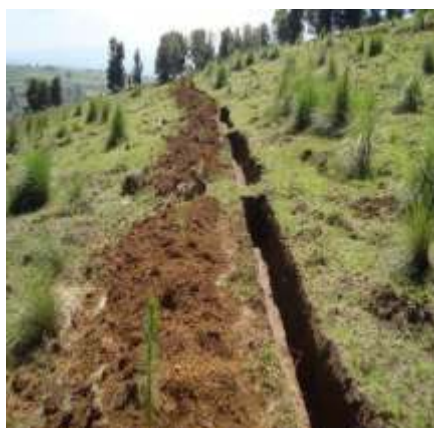
Foto 3. Zanjas bordo mas reforestación
