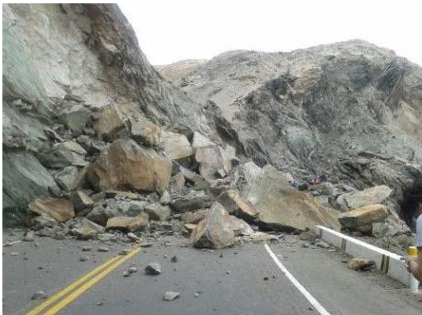
Fotografía 2: Derrumbes en Ayacucho
