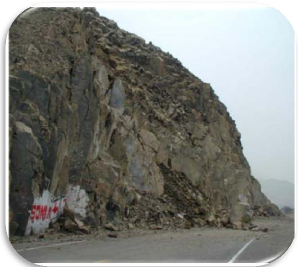
Deslizamiento por Sismo del 2001
