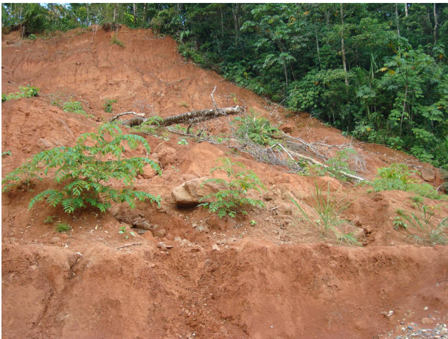
Foto 13: Erosión por deslizamiento que la estabilidad de la infraestructura de carreteras. Cercanías de Salvación.
