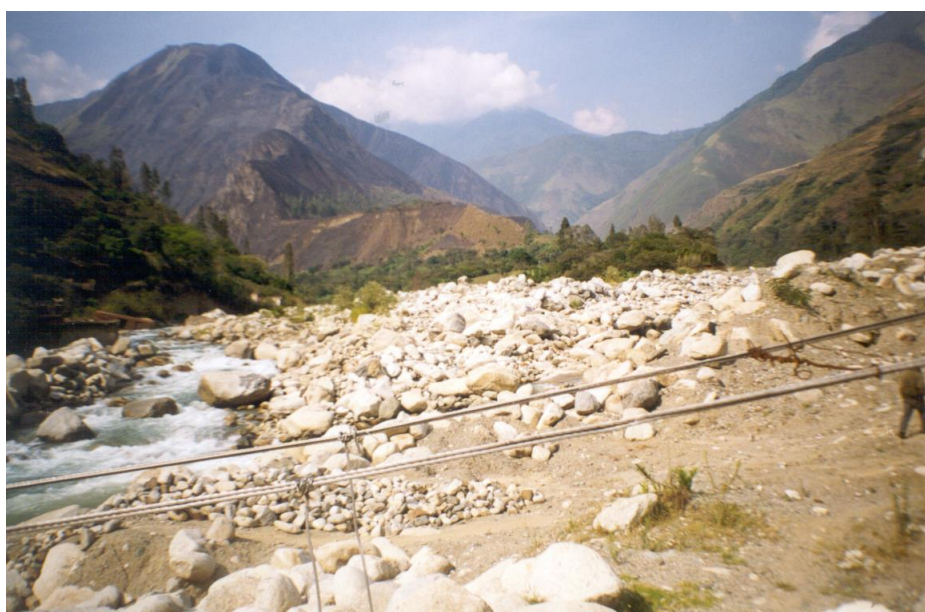
FOTO N° 12. Zona vulnerable se encuentra en el tramo comprendido entre la desembocadura del río Aobamba hasta la Ciudad de Quillabamba.
