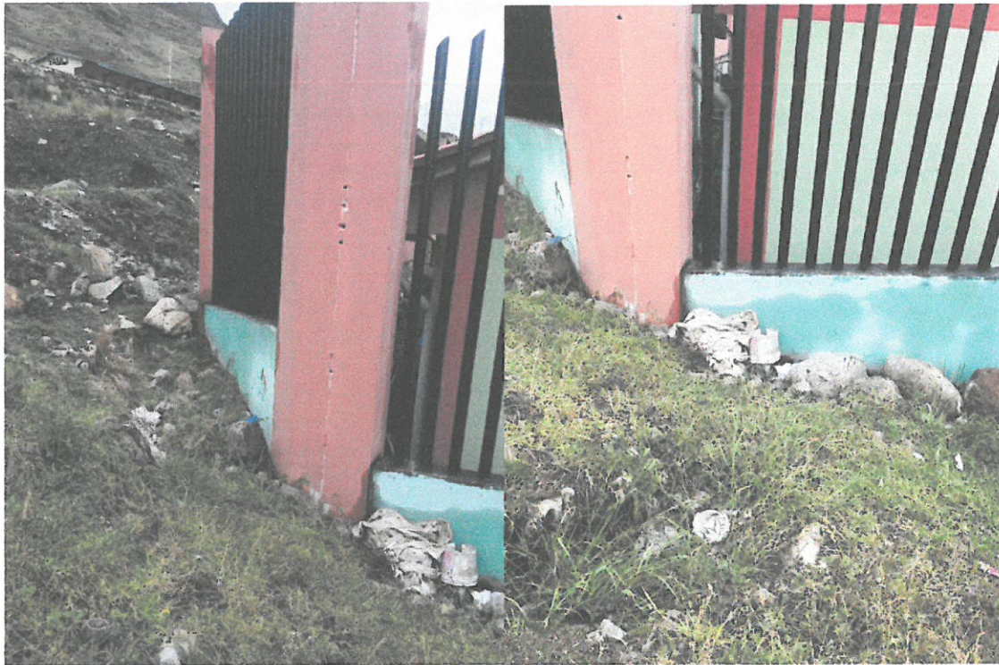
Fotografía 3: Intersección de Calle Bolívar y Calle Ferrocarril
