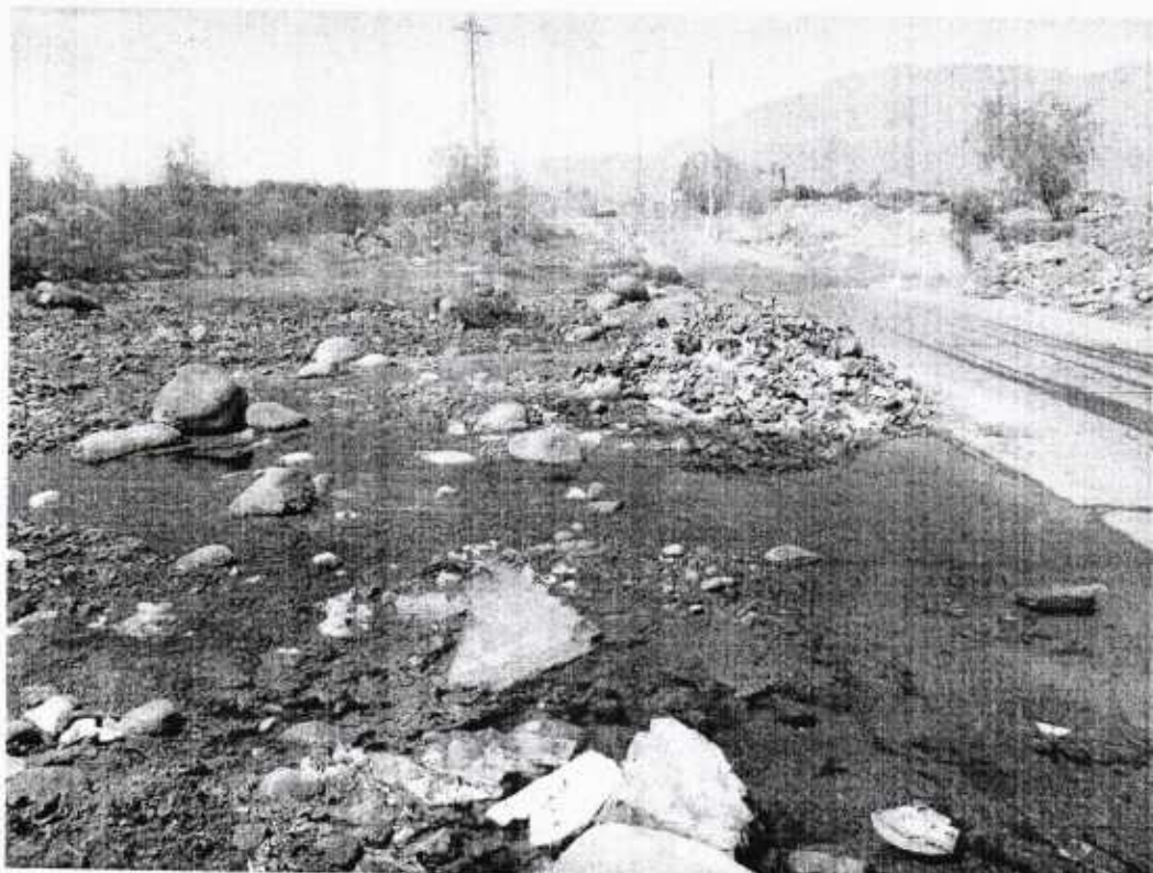
FOTO N°2: PUNTO UBICADO EN LA AV. LAS PEÑAS Y EL RIO SOCABAYA
