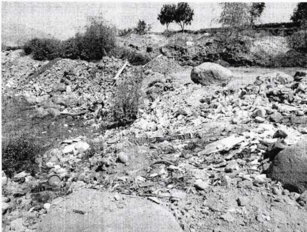
FOTO N° 3: PUNTO UBICADO EN EL PUENTE DE LA MANSION
