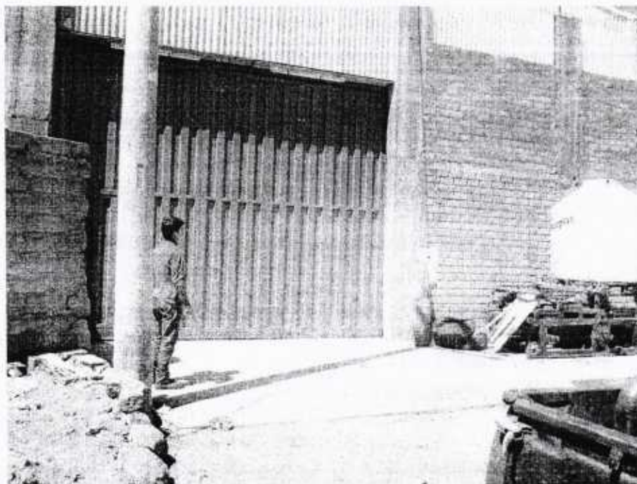
Foto in-situ donde se constató que ya no existen residuos sólidos en la vía pública
