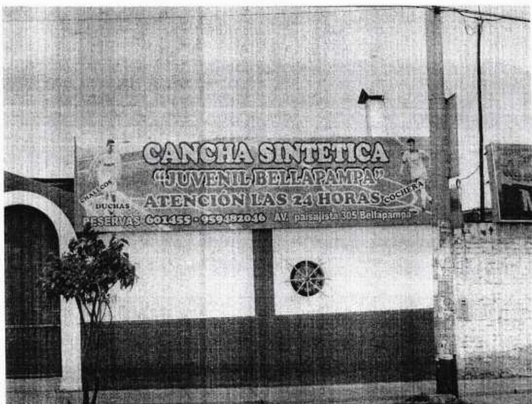
FOTO N°3: SE PUEDE OBSERVAR EL LETERO QUE SE ENCUENTRA INSTALADO EN PLENA AV. PAISAJISTA ANUNCIANDO LA CANCHA SINTETICA
