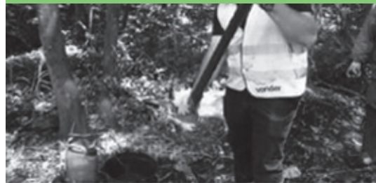
A.5. Limpieza del liner
