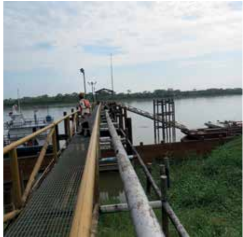
Evaluación de campo para la apertura del derecho de vía y facilidades del proyecto "Mantenimiento de Ductos en el Tramo de Batería 3 - Terminal Yanayacu, lote 8 en la Reserva Nacional Pacaya Samiria"
