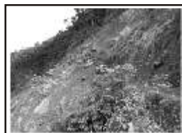
Deslizamiento Cajadela - Vía Cajadela Unión Progreso
