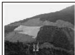
Deslizamiento Cajadela - Vía Cajadela Unión Progreso
