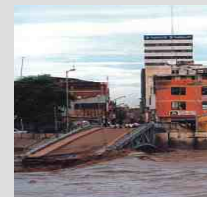
Puente sobre el Río Piura
