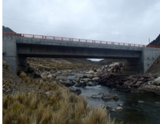
Foto n.º 2. Río Macusani a la altura del puente Huichisa
