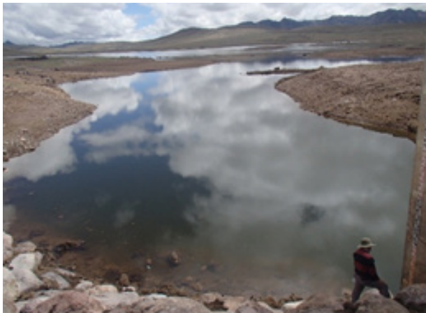
Foto n.º 5. Represamiento de la laguna Parinajota a cargo de empresa privada San Gabán
