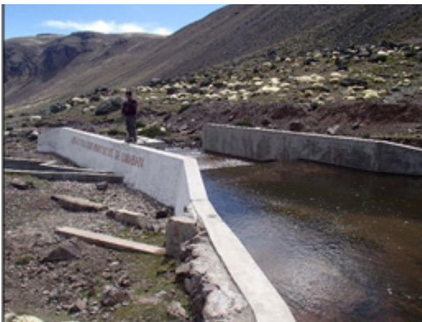
Foto n.º 7. Bocatoma Surapampa – Comunidad Campesina Pacaje
