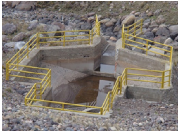
Foto n.º 6. Estructura de la salida de flujo de represamiento de la laguna Parinajota - Empresa privada San Gabán (central hidroeléctrica)
