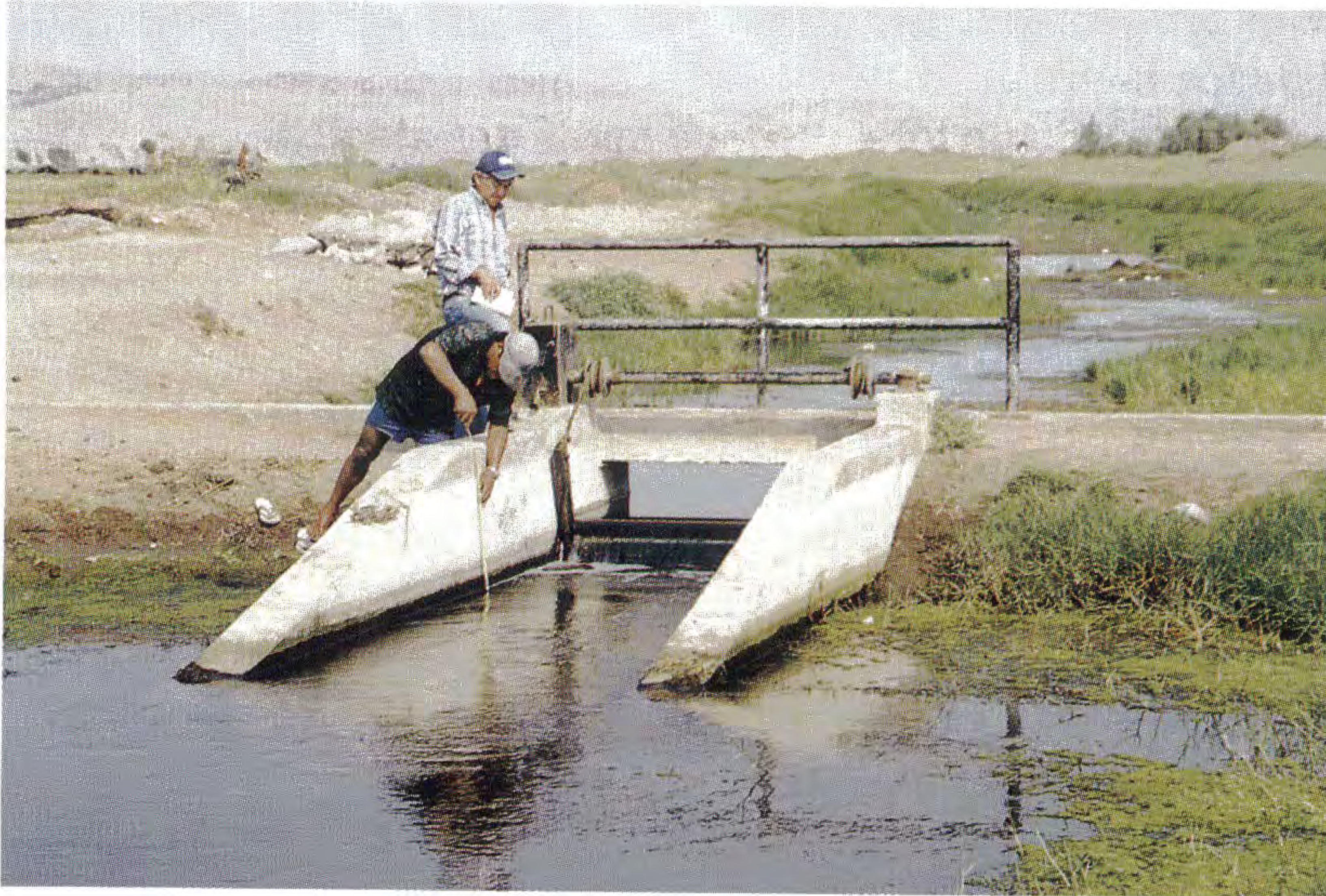
Foto 16. Obras hidráulicas: sistema de control de niveles.
