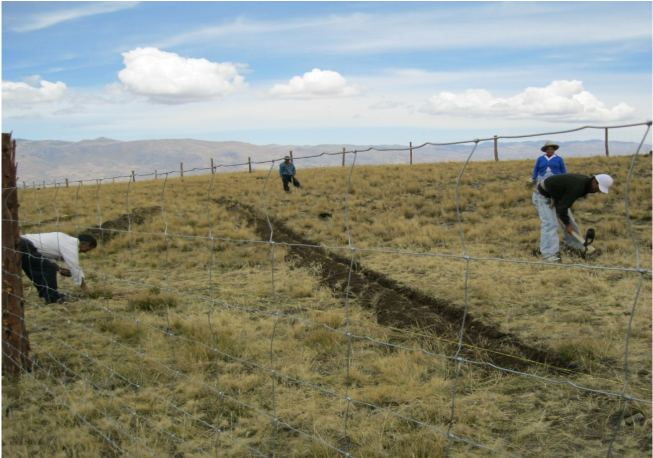
Figura n.º 30. Construcción de surcos de infiltración como estrategia para captura de agua y manejo de suelos
