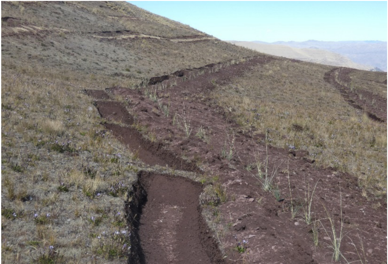
Figura n.º 29. Construcción de zanjias de infiltración como estrategia para captura de agua
