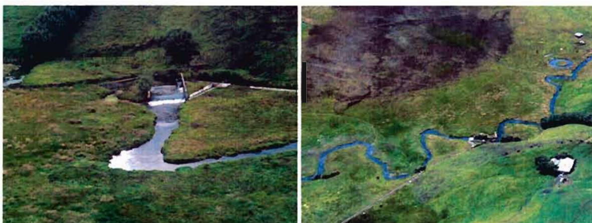
Fotografía 18. Captación y tramo inicial del canal Chailhuagón Yerbabuena.
