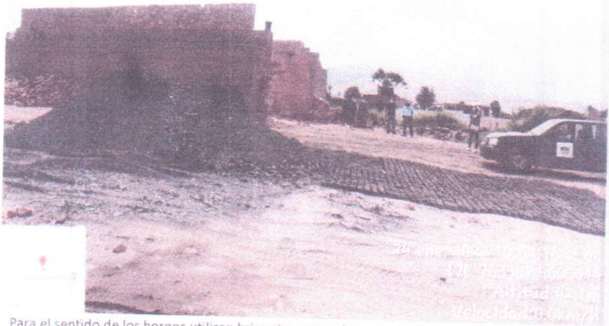
Para el sentido de los hornos utilizan briquetas, pero el armado de las mismas se realiza al costado del horno.
