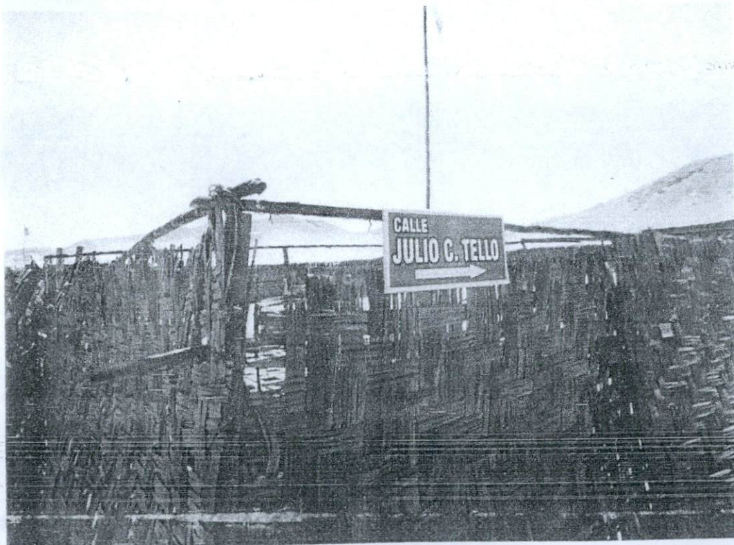
INSPECCION OCULAR A OTRA ZONA PERIFERICA DEL AA.HH. VILLA HERMOSA, CON CORRALONES CERCADO CON ESTERA. EN LOS INTERIORES NO SE OBSERVA ACTIVIDAD ALGUNA.
