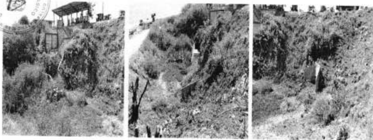
Foto N° 5, 6 y 7. Se puede observar las aguas residuales que discurren de la quebrada cruzando la carretera panamericana, Caleta Grau.
