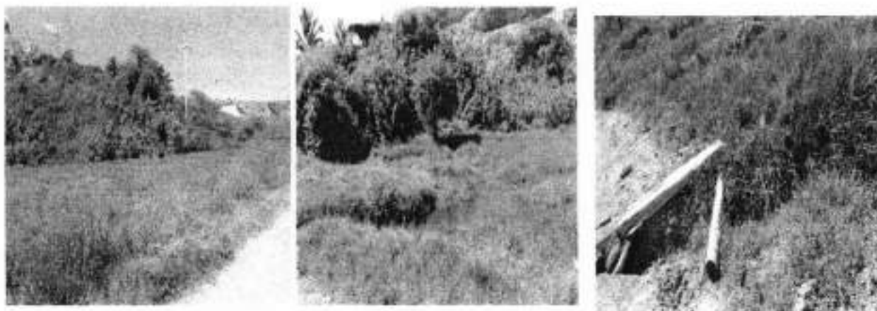
Foto N° 8, 9 y 10. Se puede observar la continuación el recorrido de las aguas residuales antes de llegar a la laguna ubicada cerca al mar. Caleta Grau.
