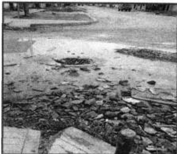
Foto N° 1. Buzón ubicado en la intersección de las calles Manco Capac y Manco Inca. AA. HH. 28 de Julio. Aguas Verdes
