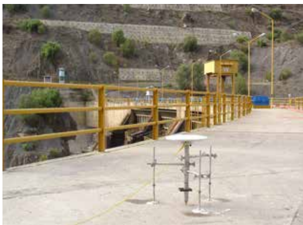
GPS con el que se monitorea la represa del Mantaro.
