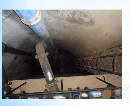
\*Es una estación de bombeo de aguas residuales para conducir las descargas de las líneas emisoras por medio de una línea de impulsión que llega hacia un emisor establecido.
