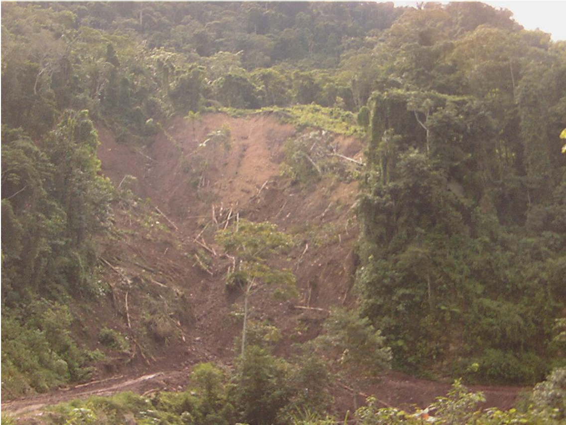
Foto 25: Zonas con problemas de erosión y derrumbes
