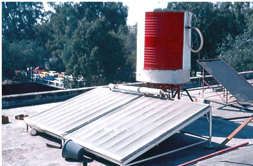
*Fig 8.9 Colectores solares planos*
