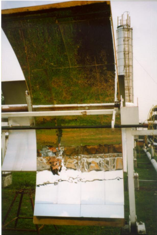
*Fig 8.12 Espejos de primera superficie desarrollada para un concentrador canal parabólico*
