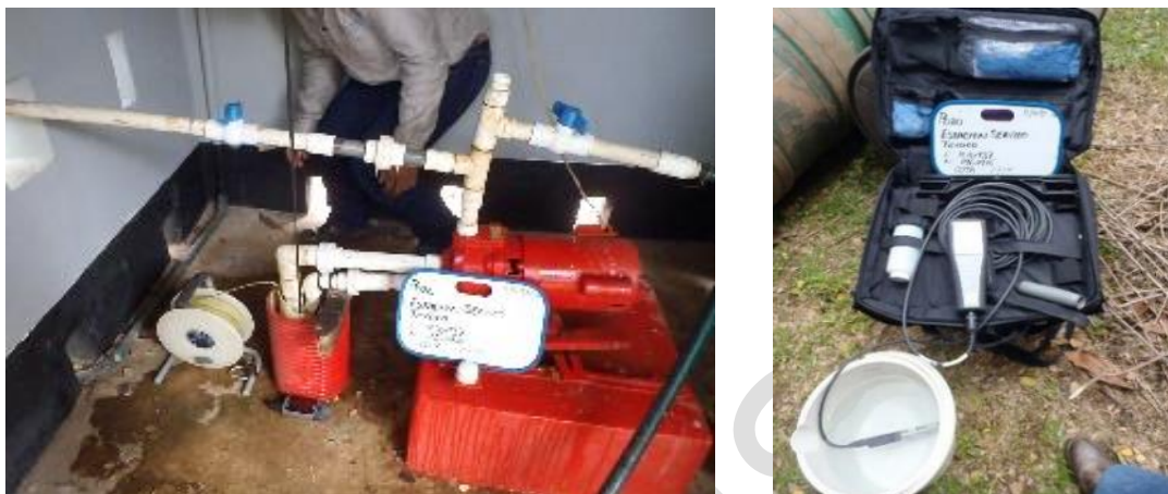
Figura 185. Medición in situ con un medidor multiparámetro en un pozo profundo de extracción.
