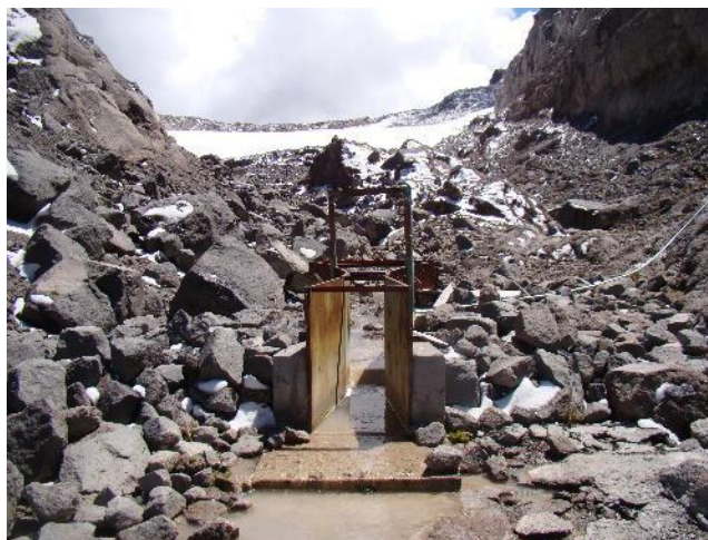
Figura 68. Canaleta Parshall, Parque Natural Nacional los Nevados. Fuente. Subdirección de Ecosistemas. IDEAM 2017.
