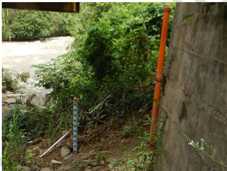
Figura 56. Maxímetro. Estación Puente Venado, río Venado. Fuente. Área Operativa 7- IDEAM 2017.
