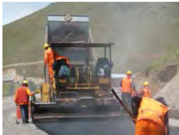
Pobladores realizando trabajos de infraestructura vial. Fuente: skyscraperlife.com.
