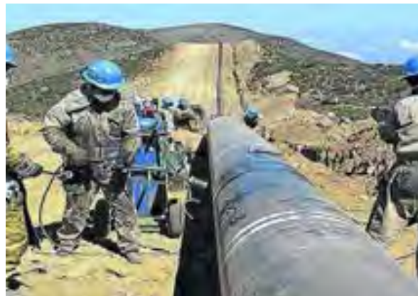
Trabajos de instalación del gas de Camisea. Fuente: Inforegión.
