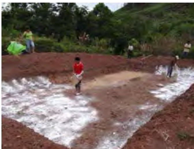
Construcción de piscigranja – Incremento de la economía familiar. Fuente: CORAH
