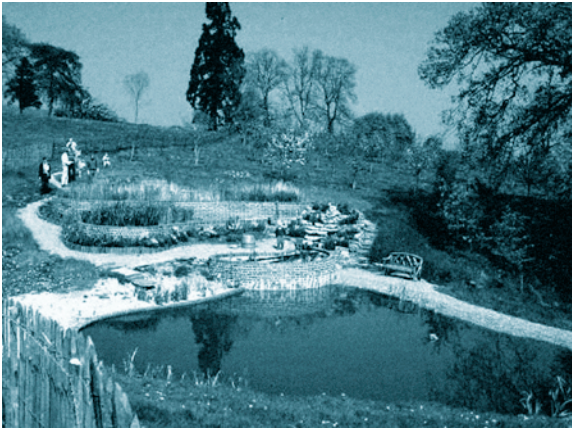
FOTOGRAFÍA 1. Lagunaje en cola de una instalación de humedales artificiales. (Oaklands Park, Reino Unido).
