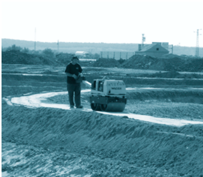
FOTOGRAFÍA 33. Compactación de la coronación de las lagunas.
