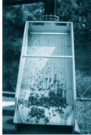
FOTOGRAFÍA 5. Tamiz estático autolimpiante.
