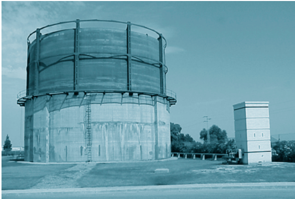
FOTOGRAFÍA 21. Gasómetro para el almacenamiento del biogás generado en la etapa de estabilización anaerobia de los lodos.
