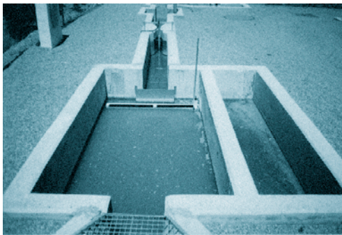
FOTOGRAFÍA 8. Desengasador estático.
