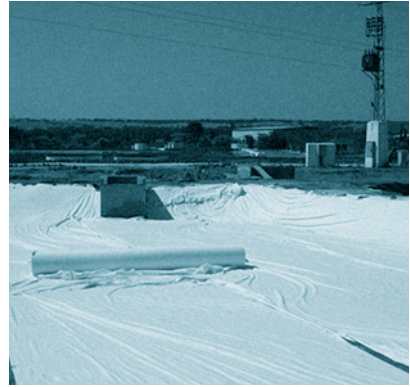
FOTOGRAFÍA 5. Colocación de la lámina de geotextil.
