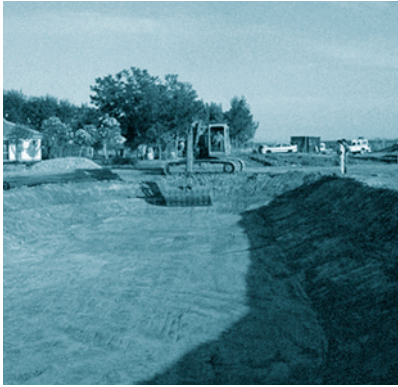
FOTOGRAFÍA 4. Excavación del vaso de los humedales.
