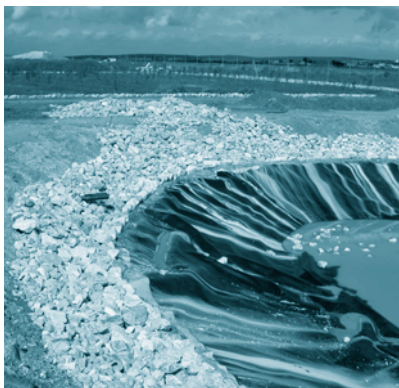
FOTOGRAFÍA 36. Encachado de los taludes.
