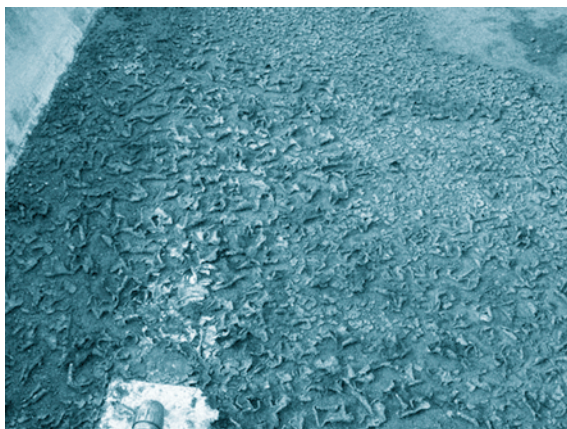
FOTOGRAFÍA 12. Aspecto de la costra que se forma en la superficie de los filtros una vez seca.
