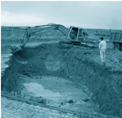
FOTOGRAFÍA 27. Excavación del vaso de lagunas anaerobias.
