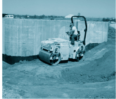
FOTOGRAFÍA 30. Relleno y compactación del terreno.
