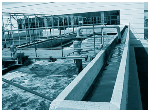
FOTOGRAFÍA 9. Desarenador-desengasador aireado.
