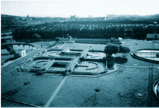
FOTOGRAFÍA 17. Reactores tipo carrusel, con zonas óxicas y anóxicas para la eliminación biológica de nitrógeno.
