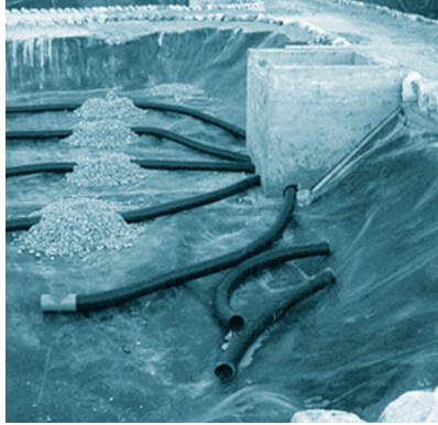
FOTOGRAFIA 11. Conexión de las tuberías de drenaje con la arqueta de salida.
