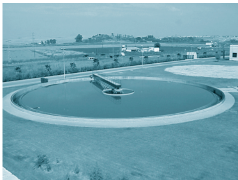
FOTOGRAFÍA 13. Decantador primario.
