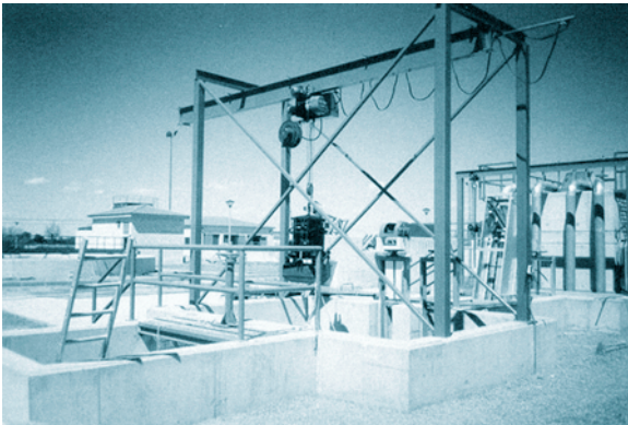
FOTOGRAFÍA 2. Pozo de gruesos y cuchara bivalva.
