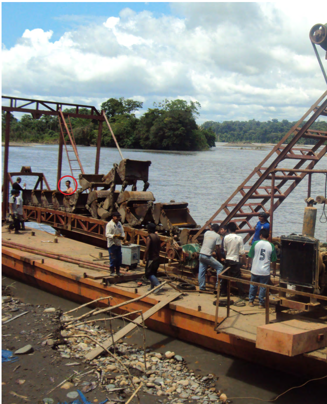
Fotografía de Marie Emilia Coelho, construcción de una nueva draga en el río Inambari en la comunidad nativa Azaire, donde se evidencia la presencia de mineros asiáticos
