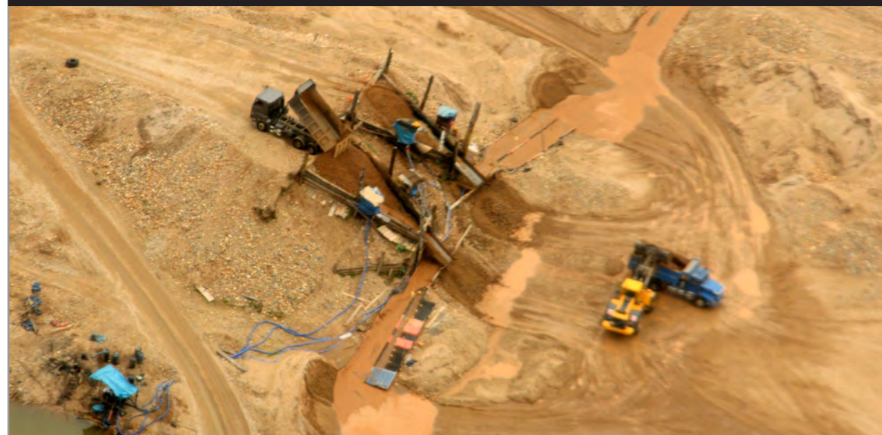
Camiones trabajando en la comunidad nativa de Kotsimba
