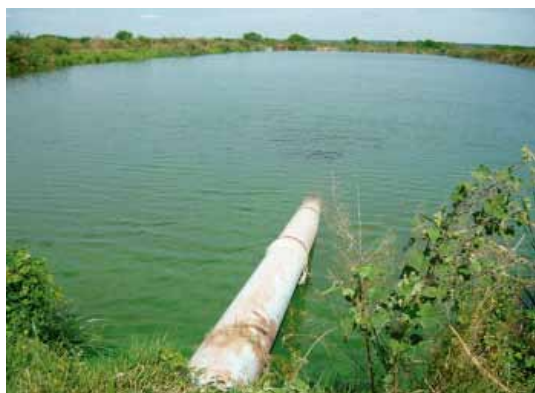
Fotografía 1: Laguna de tratamiento
