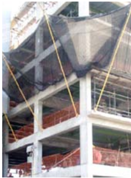
Foto 28. EPCs acorde a los peligros, redes, barandas y señalización
