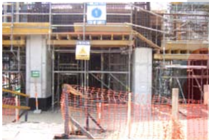
Foto 29. EPCs acorde a los peligros, barandas y señalización
