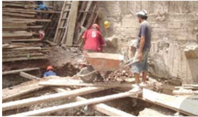
Foto 3. Excavación manual
