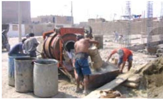
Foto 7. Preparación de concreto
