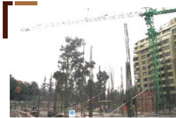
Foto 34. Equipo de transporte vertical y horizontal (grúa torre)
