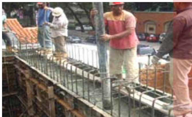
Foto 8. Vaciado de concreto
