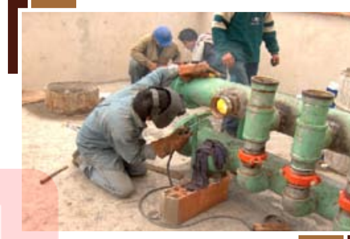
Foto 9. Soldadura en instalaciones electromecánicas
