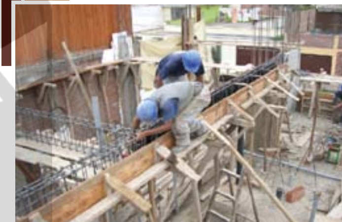
Foto 6. Colocación de acero
