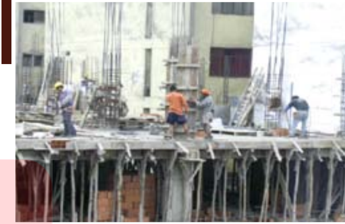
Foto 5. Encofrado y desencofrado
