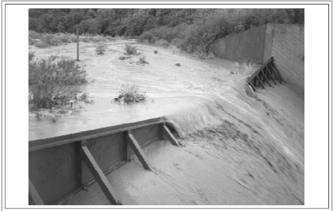
Figura 3.8. – Vertedero Triangular en el torrente Divisadero Largo (Mendoza, Argentina INA – Centro Regional Andino ) calibrado en modelo físico en laboratorio.
