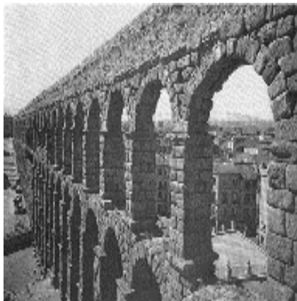
Figura 1.1. Acueducto de Segovia construido en el siglo de Augusto. Estas construcciones se hacían con el fin de conducir el agua necesaria para menesteres diarios. El aquí reproducido tiene una altura máxima de 31 metros y sus similares están sobrepuestos, sin mortero que los una.
