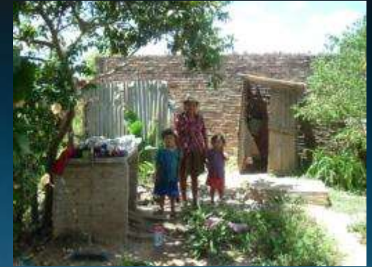
LETRINAS MAL CONSTRUIDAS
