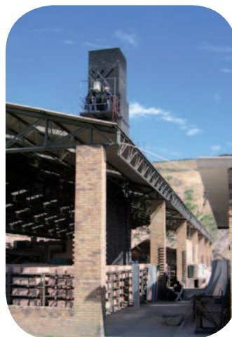
Emisiones de fuentes fijas - Ladrillera
