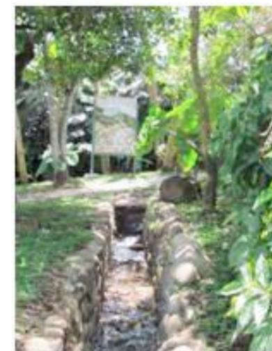
El HA se construyó sobre una base de plástico de 0,7 mm de espesor, y sobre esta se colocó la piedra. La distribución de rocas en este sistema consiste en piedra tipo gavión a la entrada y salida (tamaño 4 y 5 pulgadas) y piedra cuarta en el centro (tamaño entre 3/4 y 1 pulgada). Acepesa diseñó y construyó el sistema.
