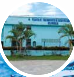
Planta de Tratamiento de Agua Potable
