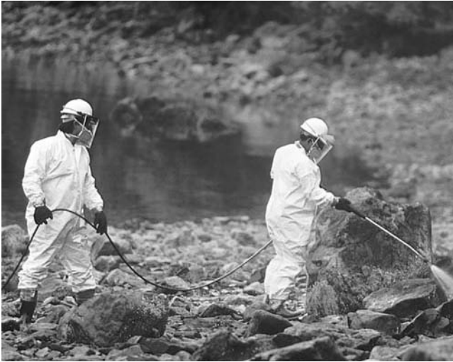
Figura 9.18 Utilización de fertilizantes para estimular a los microbios que degradan petróleo Los trabajadores en las zonas de limpieza rocían fertilizantes ricos en nitrógenos sobre una playa empapada de petróleo en Alaska después del vertido del Exxon Valdez. Los fertilizantes aceleran mucho el crecimiento de las bacterias naturales que degradarán el petróleo.
