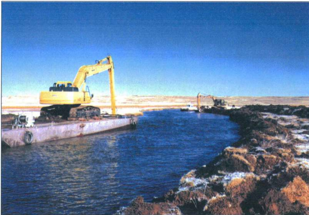
Dragado del Río Desaguadero en su tramo inicial. (Puente Internacional - Nazacara).
