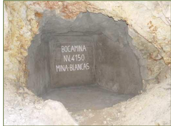
Foto N° 2. Cierre de bocamina sin drenaje, Julcani
