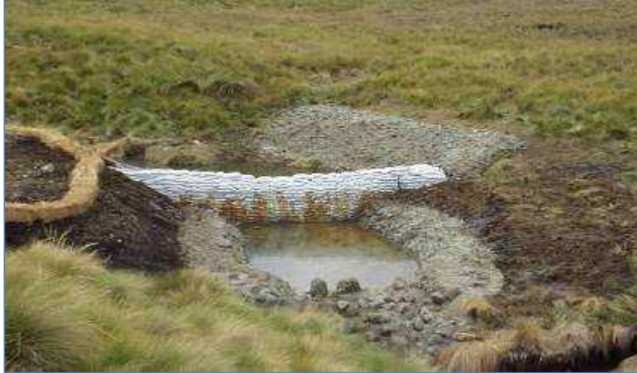
Foto N° 4. Estructuras de sacos con concreto
