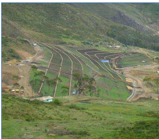
Foto N° 12. Gavión culminado, construcción de cuneta cancha revegetada. Colquirrumi
