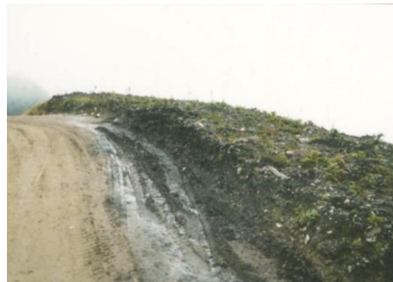
Adecuación de bermas por alteración de apertura de vías, siembra realizada sobre ésta como recuperación visual y paisajística
