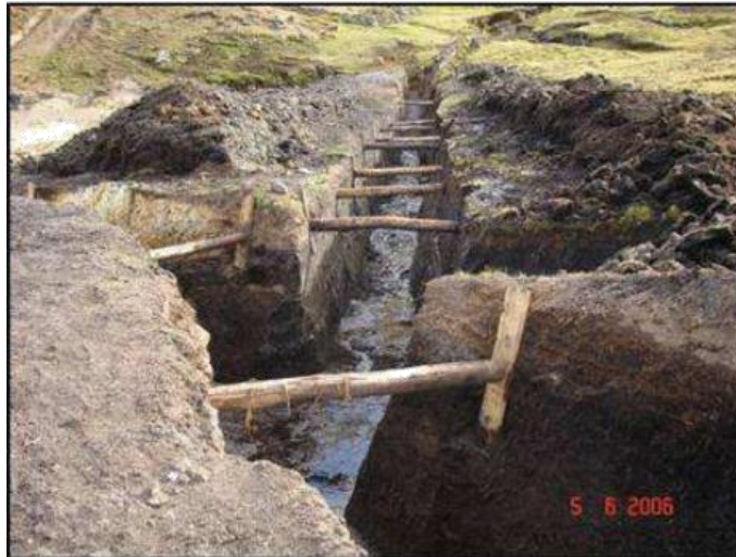
Foto N° 9. Zanjas de derivación
