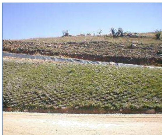
Foto N° 2. Restauración de talud en etapa inicial con geoceldas, capa superficial del suelo E.
