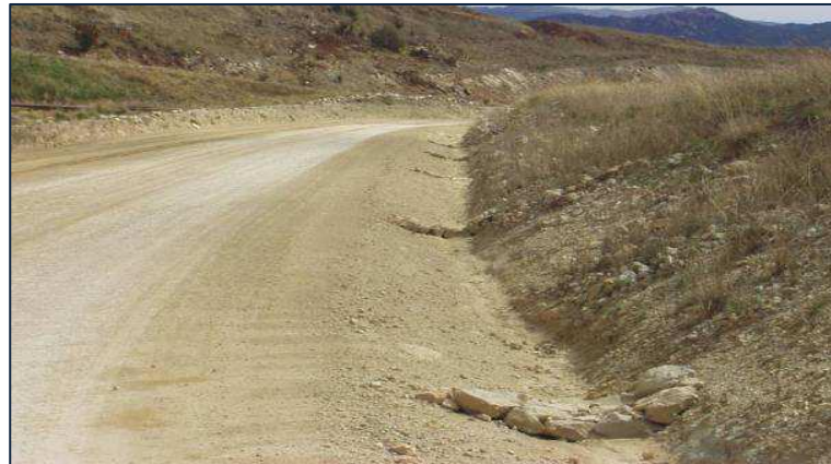
Foto N° 8. Drenaje de camino
