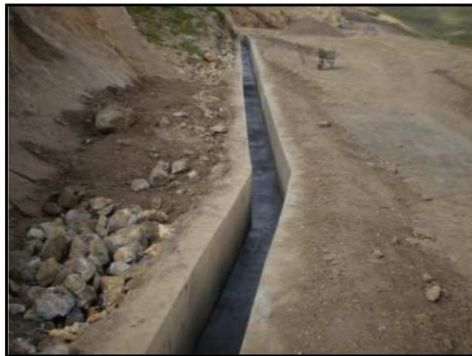
Foto N° 10. Canales de coronación emboquillados de piedra
