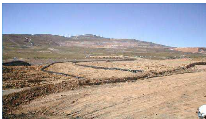
Foto N° 6. Aplicación de la cerca de sedimento
