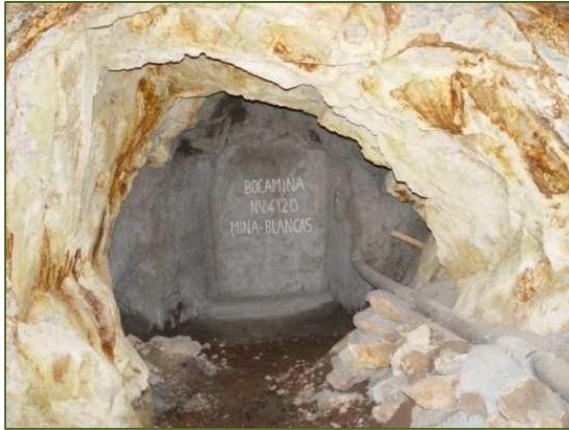
Foto N° 1. Cierre de bocamina con drenaje, Julcani
