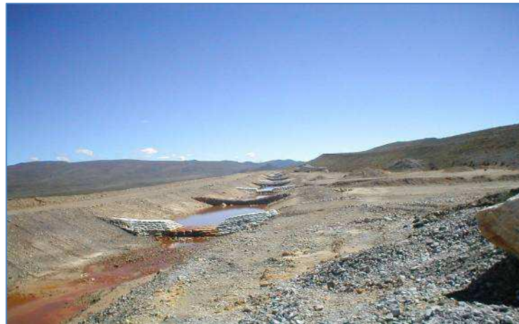
Foto N° 7. Aplicación de las presas de retención
