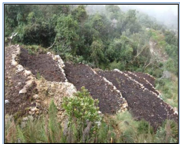
Foto N° 13. Rehabilitación de plataformas de perforación. La Zanja
