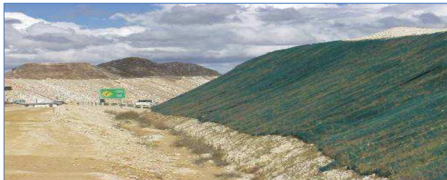
Foto N° 3. Mantas para el control de la erosión
