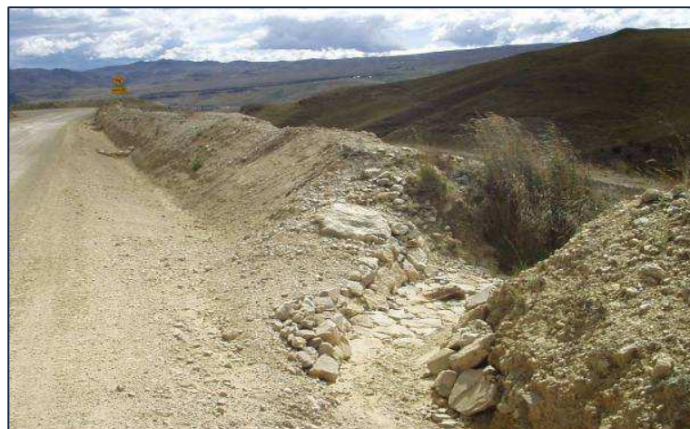
Foto N° 10. Abertura de Berma
