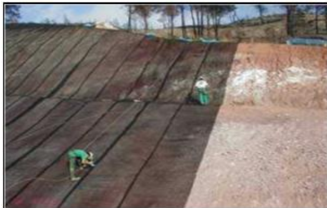
Foto N° 12. Recubrimiento de un área con geomembrana
