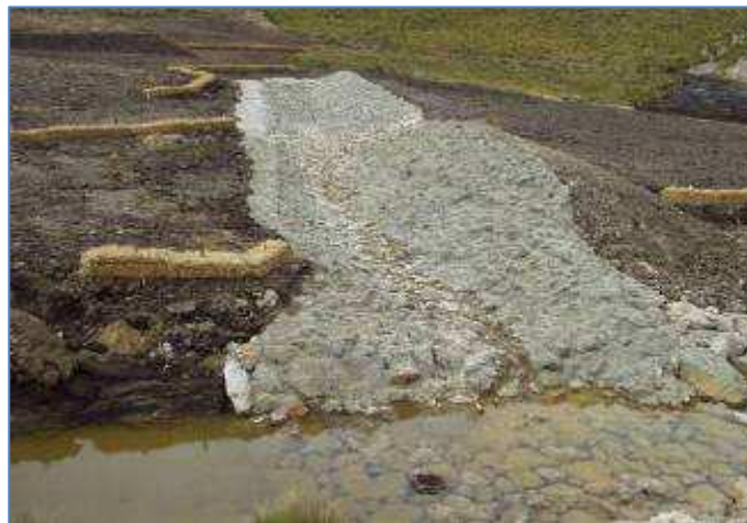
Foto N° 1. Canal con rip-rap con lechada de concreto
