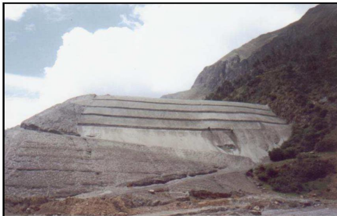
Foto N° 14. Preparación del talud de una relavera 3 400 msnm
