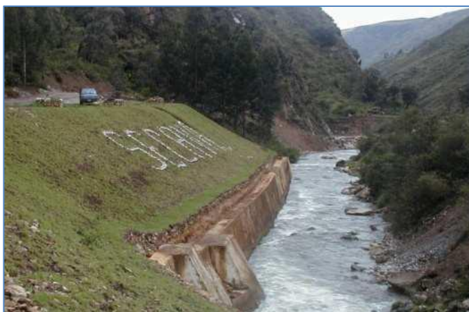
Foto N° 15. Cancha revegetada con Kicuyo y Muro de contención Río Huallaga 3400 msnm
