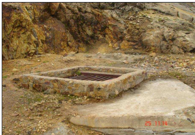
Foto N° 5. Cierre de chimeneas
