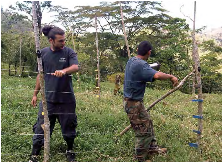
Figura 4. Instalación de una cerca eléctrica en una finca del proyecto. Foto: Daniel Corrales-Gutiérrez, Panthera Costa Rica.
