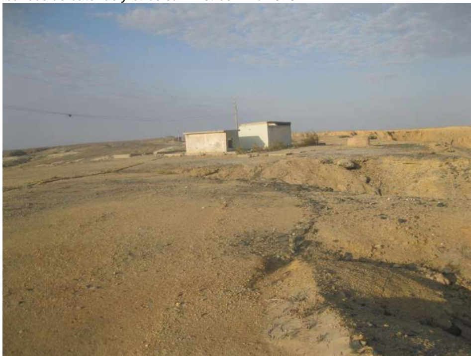
Figura 8. La foto muestra la casa del personal de mantenimiento y la caseta donde se ubicaron los bancos de baterías y otros suministros. Año 2016.
